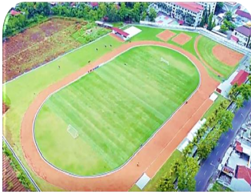
Komplek Stadion Atletik Wates
